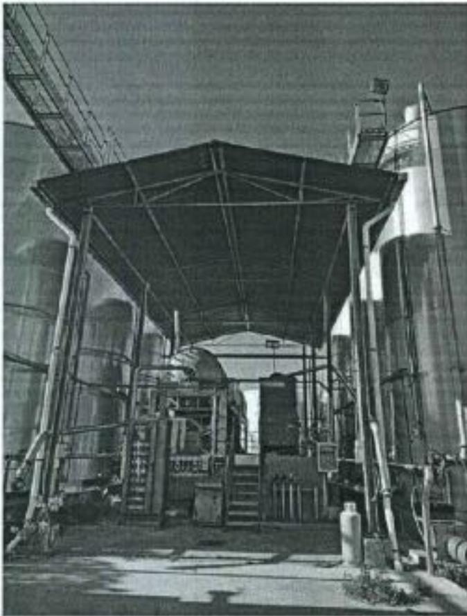
Con la lettera F è indicata la valutazione della struttura in ferro "tettoia" con copertura in lamiera zincata, pilastri in ipe e capriate in ferro, realizzata per la protezione delle presse per la lavorazione delle uve. Nei pressi sono presenti anche serbatoi in acciaio inox, la cui descrizione è rimandata al paragrafo 4.12 dedicata ai serbatoi e cisterne.
